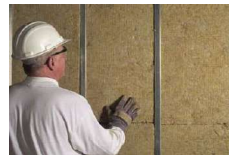
REALIZZAZIONE DI INTONACO ISOLANTE INTERNO ED ESTERNO
