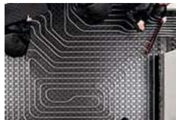
SISTEMA DI RISCALDAMENTO A PANNELLI RADIANTI A PAVIMENTO
